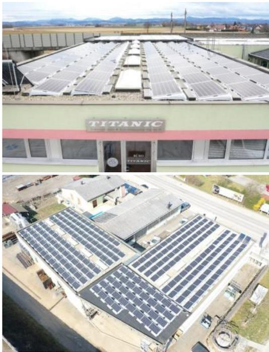
Insgesamt wurden 256 Stück Photovoltaik-Module verbaut. Diese bringen eine Gesamtleistung von 81,92 kW.
